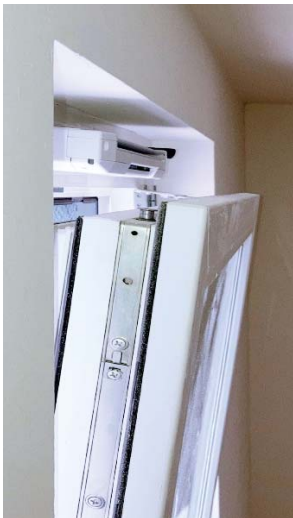
Bild 2: Arbeiterleichterung: Außenbauteil-Luftdurchlässe (ALD) für die freie Lüftung werden für den Blower-Door-Test zum öffentlich-rechtlichen Nachweis nach GEG nicht mehr abgedichtet. Foto: FLiB e. V.
